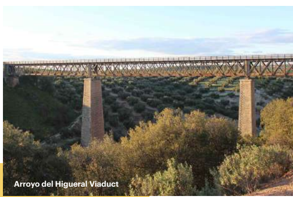
Arroyo del Higueral Viaduct
