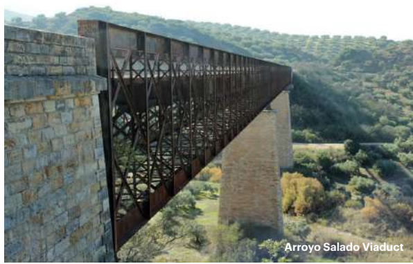
Arroyo Salado Viaduct
